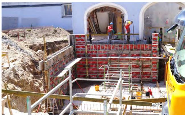
Nachdem die ersten Vorbereitungen für die Baumaßnahmen getroffen worden sind, wurde bereits die Bodenplatte für das Untergeschoss betoniert und die Seitenwände können damit gesetzt werden.
