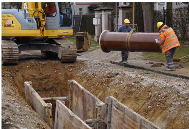
In der Richterstraße werden die neuen Kanalrohre in einer Tiefe von bis zu 5 Metern verlegt.
