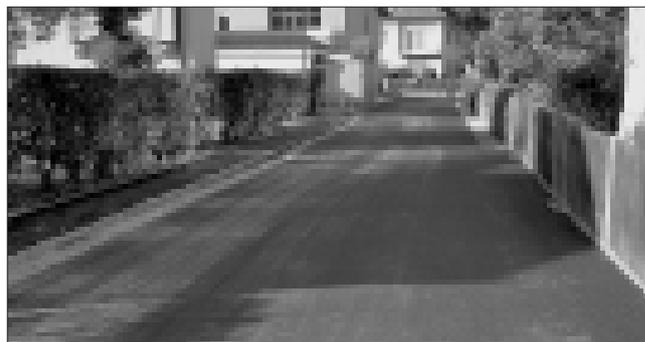
Mit der notwendigen Sanierung der Badgasse wurde begonnen. Betonleistensteine sichern den Hang ab. Der Feinasphalt wird in den nächsten Tagen aufgetragen.
