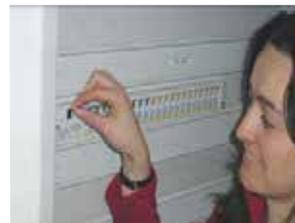
Alle Fehlerstromschutzschalter sind mit einer Prüftaste zum Funktionstest ausgestattet. Wird die Prüfung nicht durchgeführt, können die Kontakte verkleben. Ein Auslösen im Fehlerfall ist dann nicht möglich.
